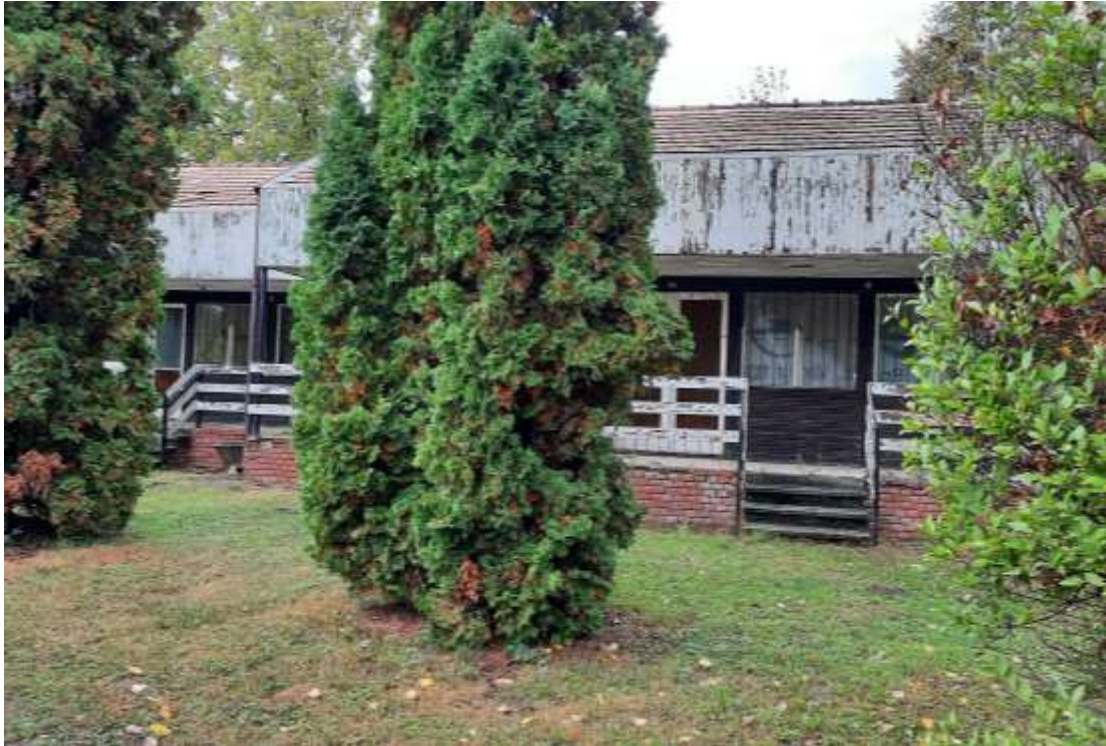
4049 hrsz. telek beépítése
