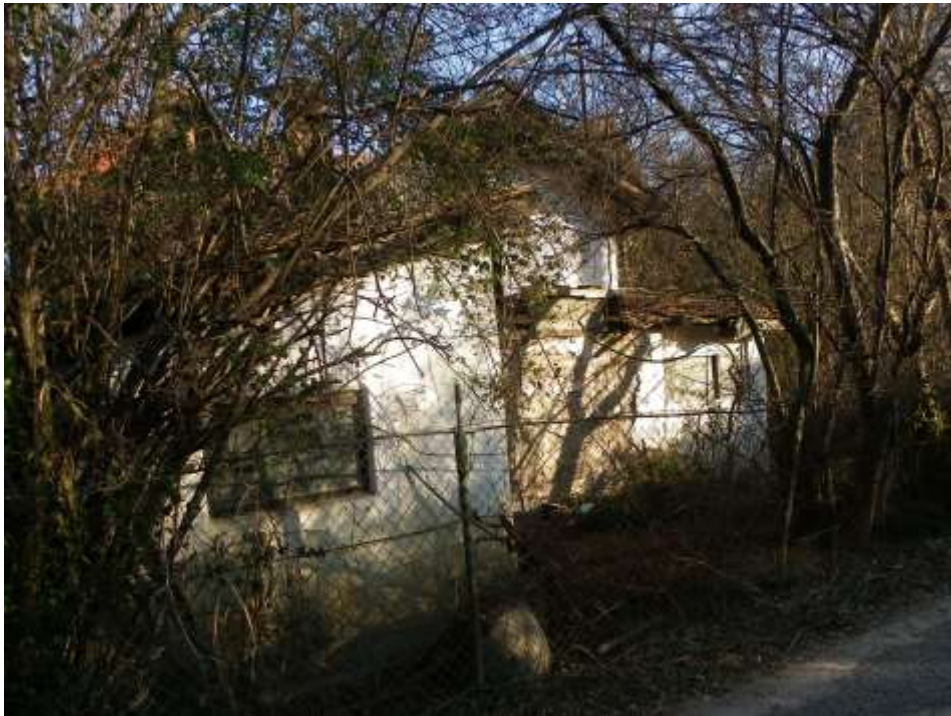
A 4062 hrsz.- telek Csárda utca felől
