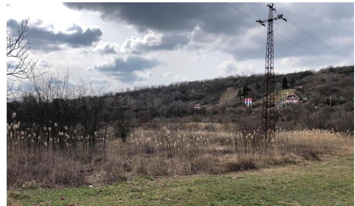
4-7. ábra: A tervezett völgyhíd helyének mai környezete (Forrás: Bősze Sándor, saját fénykép. 2021.03.15)
